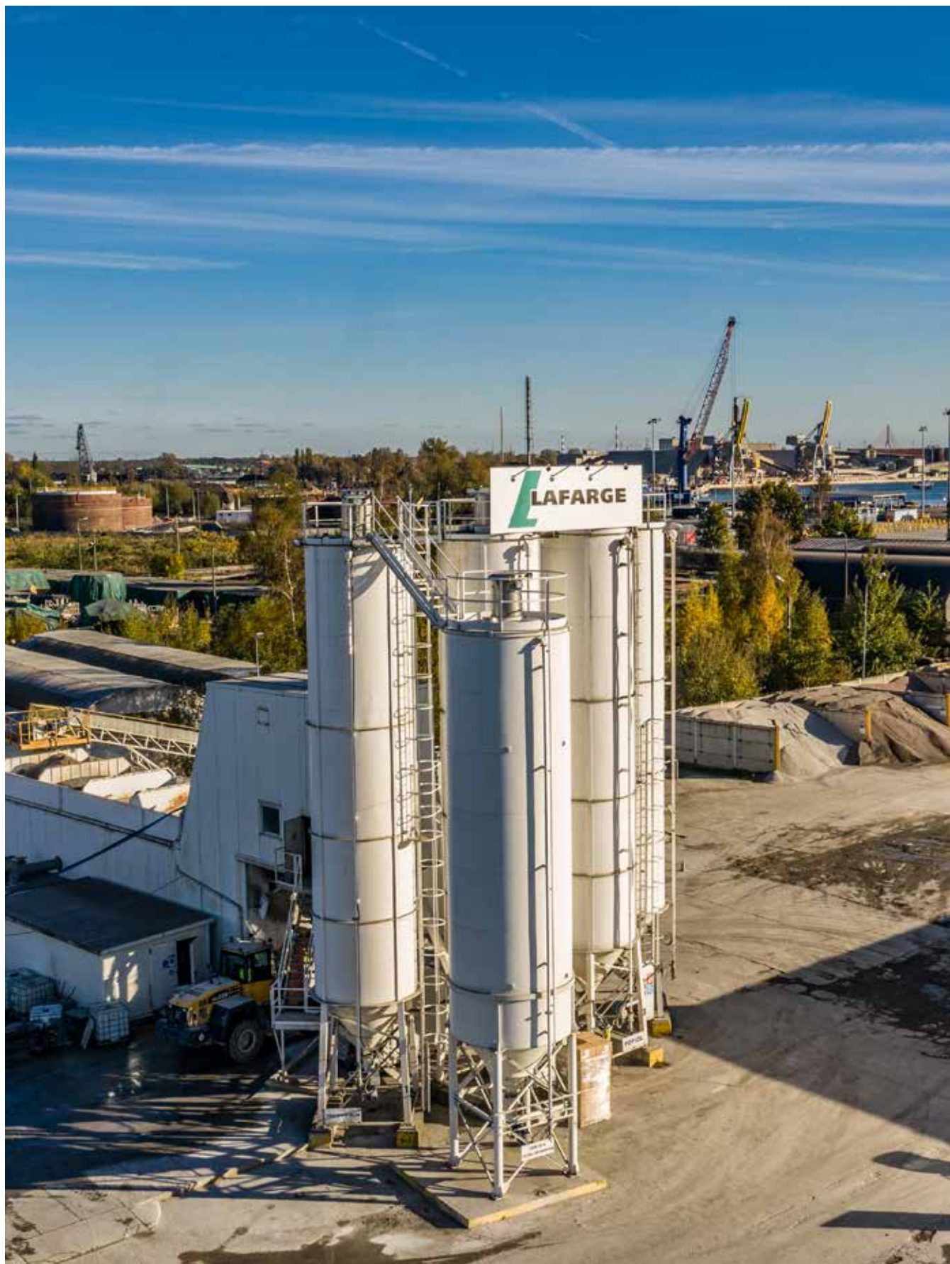
Wytwórnia Betonu Towarowego w Gdańsku
