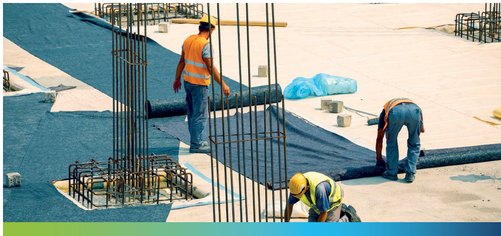
Zdjęcie 4. Zabezpieczenie płyty fundamentowej geowłókniną, styropianem i osłoną z folii
