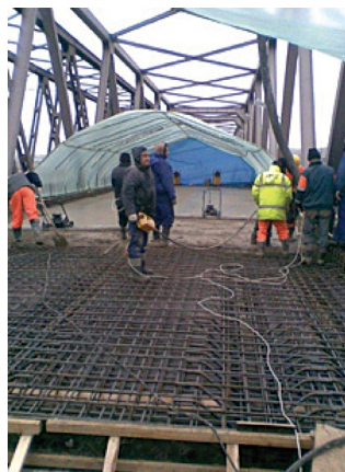
Zdjęcie 5. Wykonanie robót z zastosowaniem ciepłaka
