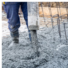
ławy i płyty fundamentowe
