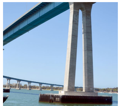
Elementy podwodne murów oporowych
