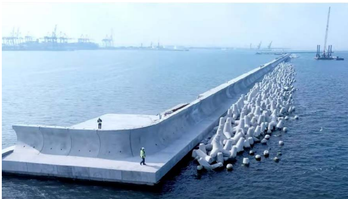
▲ Falochron Północny w Gdańsku zrealizowany z wykorzystaniem betonu Lafarge. Źródło zdjęcia: PORR, Łukasz Malkiewicz.
