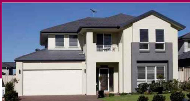
Dom jednorodzinny z podbitką dachową z płyty NIDA Hydro
