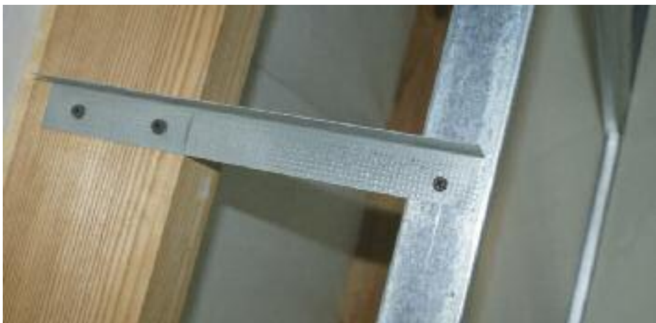
Zdj. 1. Wieszak do poddaszy zastępowany jest elementem wyciętym z profilu NIDA MFC2330
